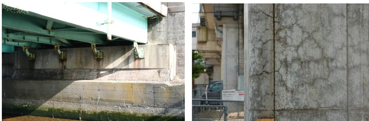
図12-1：道路橋の橋台部分（左）や鉄道構造物の橋脚（右）に見られるひび割れ
